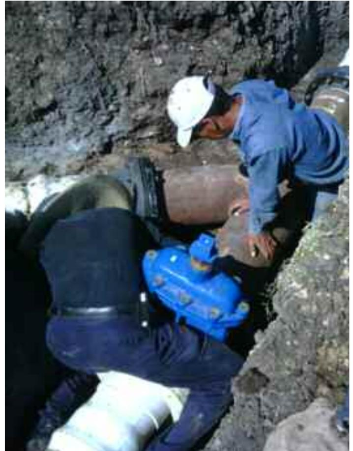
La línea de agua de Belén y el sistema troncal de distribución de agua en la cabecera municipal con una longitud aproximada a 20 km y 8 pulgadas de diámetro, es de material de asbestocemento de 30 años de antigüedad, por el tipo de material y su antigüedad es necesario su cambio.
